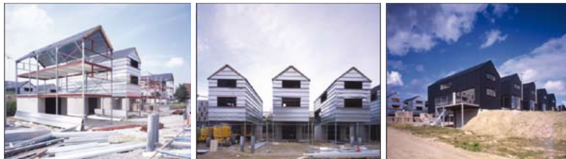
MISE EN OEUVRE DES 26 MAISONS DE CHANTEPEIE (35)
